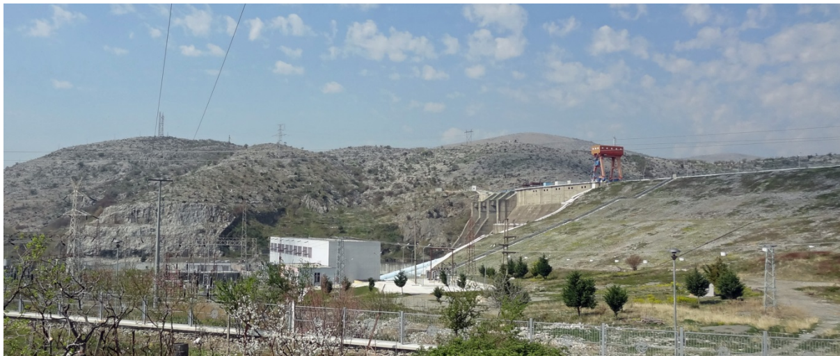
Figura 9.2: Diga e Vau të Dejës që tregon stacionin e turbinës dhe nënstacionin elektrik
