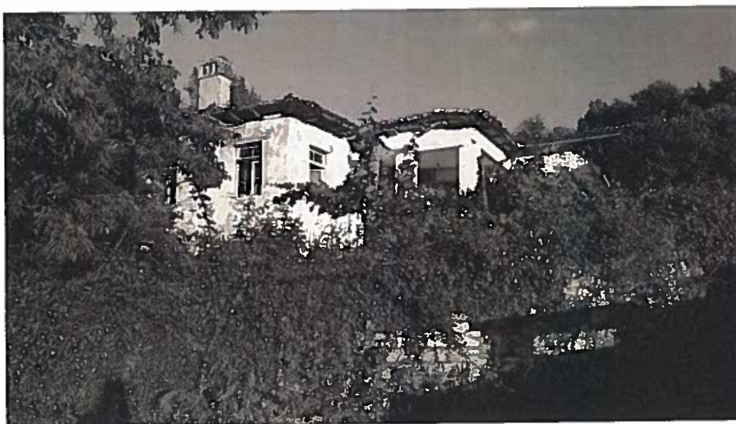
Fig. 14 Imazh ilustrues i një banesë të pozicionuar ne zone të tjetër të fshatit
