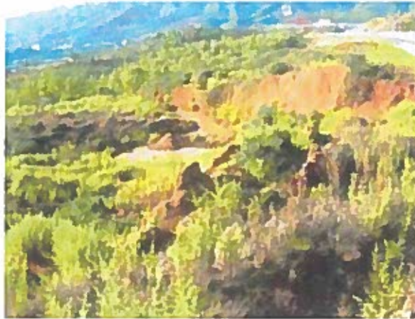
Figura 4.1.4.1 Rrëshqitje në depozitimet e N2(Ndërfushaz) (Burim: SH.GJ.SH. 2014 "Gjeoresurset dhe Gjeorrezizqet në Qarqet e Shqipërisë, Qarkut i Lezhës").
