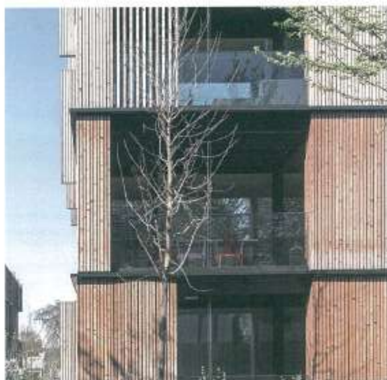
Vertically arranged timber facade with timber louvres Fasadë druri të pozicionuar vertikalisht me dritare druri me grila
