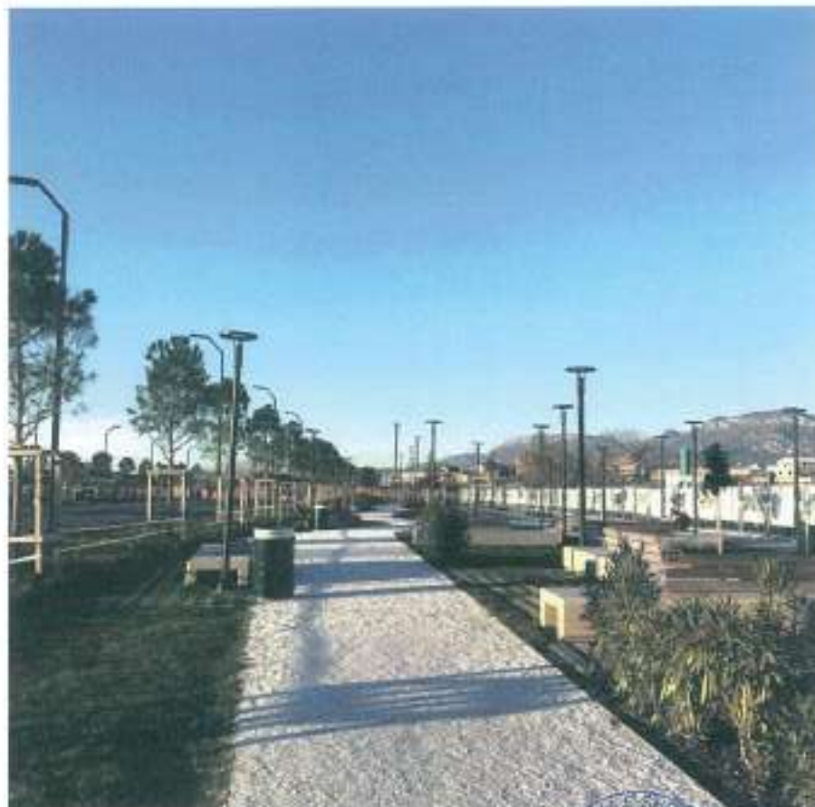
Example from the boulevard: FF8 Self-binding gravel Shiritës vetëmbidhëse - FF8 dhe setlet - FF2
