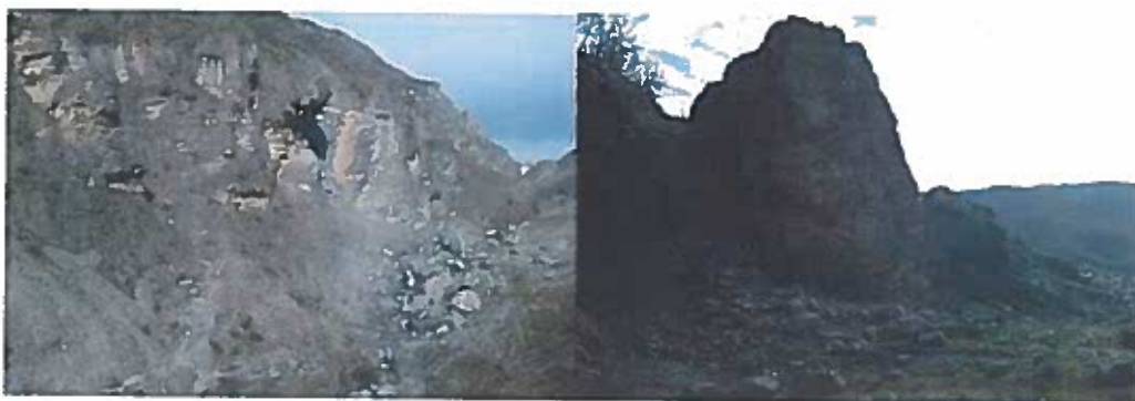
Fig. - 81 Pamje e shembjes së blloqeve shkëmbore në Fshat (përroi i Buzmadhes). Ka raste kur fenomeni i rrëshqitjes shoqërohet dhe me shembje të masave shkëmbore elementi rreziku.
