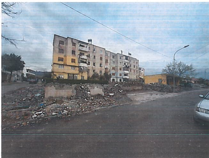
Figura 9 Pallati në rrugën "Iliria",
