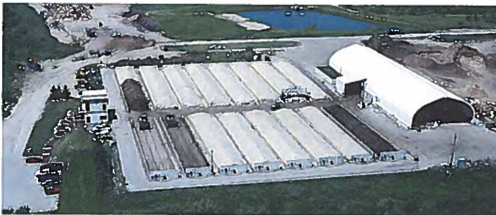
Figura 47 Shembull impianti që përdor membranë gjysëm të përshkrueshme për kompostim 29
