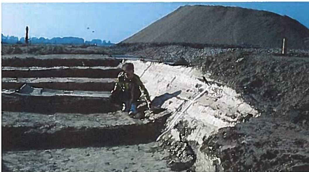
Figura 58 Shtresat e sistemit izolues fundor të vend depozitimit sipas standardeve të BE
