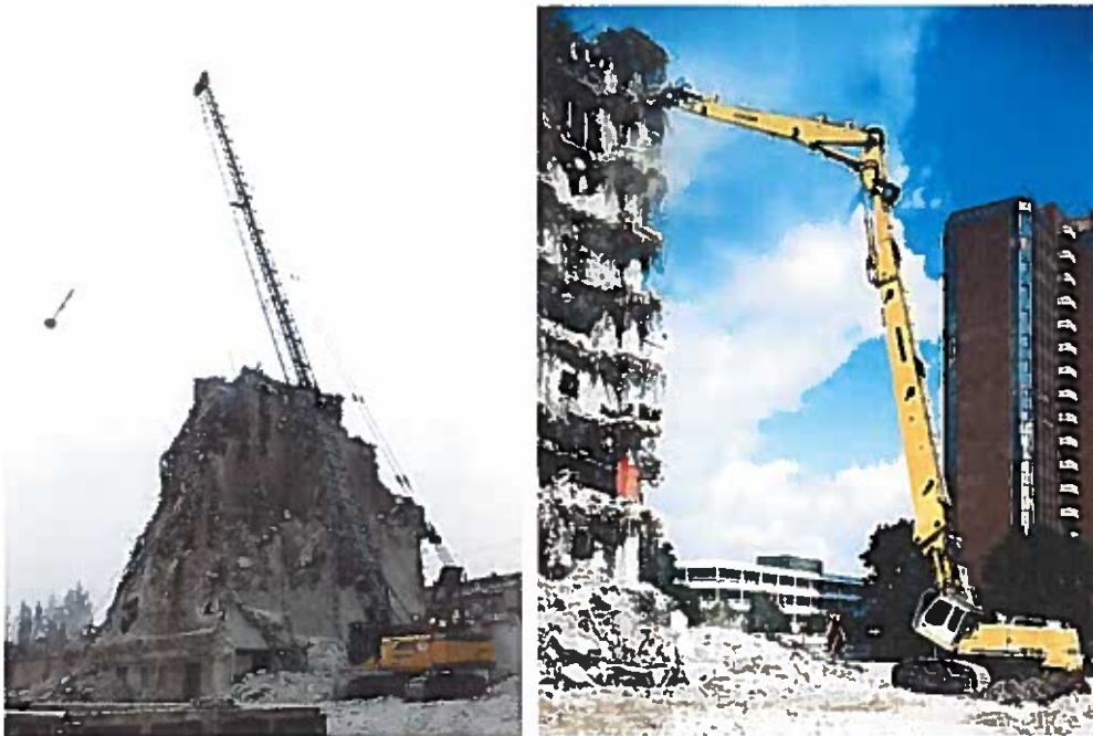
Figura 61 Majtas: prishje me vinç me top shkatërrues 49 , djathtas: prishje e kontrolluar me një eskavator 50
