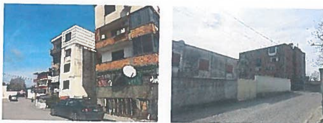
Figure 7. Foto të gjendjes ekzistuese, Rr. Mihal Mihali
