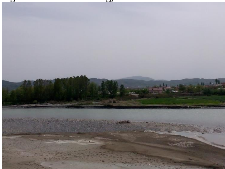
Figura 46. Dëmtime të brigjeve të lumit Shkumbin
